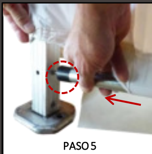
Introducir la punta la barra en el hueco dispuesto en la columna Qualytent
